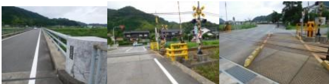
※阿金谷橋（竹野川）、阿金谷踏切、竹野東踏切
